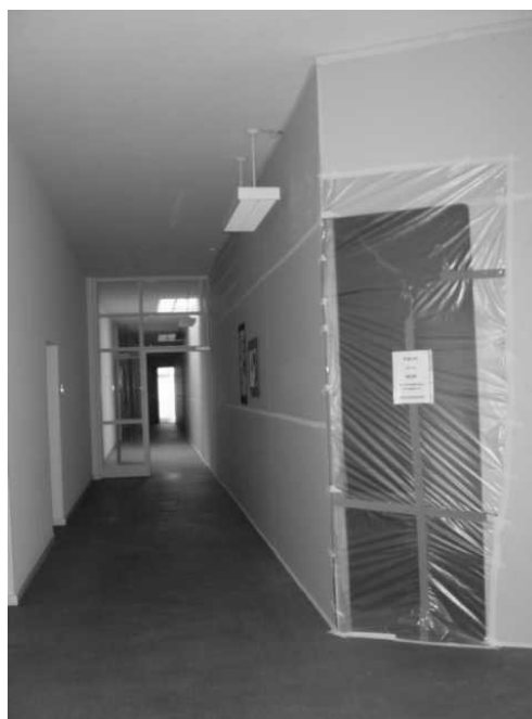
Zweite Etappe der DIPF-Renovierung
